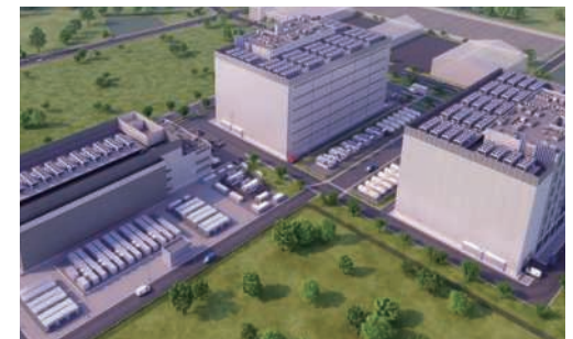
AirTrunkのデータセンター(日本)
